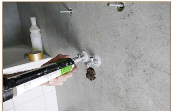
**12. Öffnungen mit Silikon ausspritzen und Armaturen montieren**
